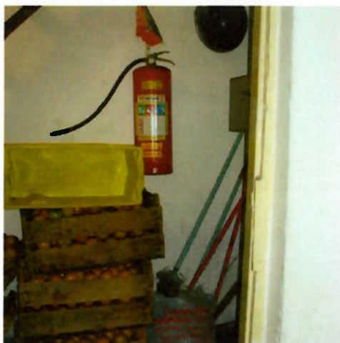
Figura 23 – Extintores obstruídos
