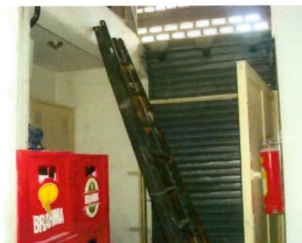
Figura 22 – Extintores obstruídos
