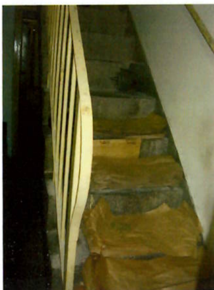
Figura 17 – Escada com material impedindo a passagem
